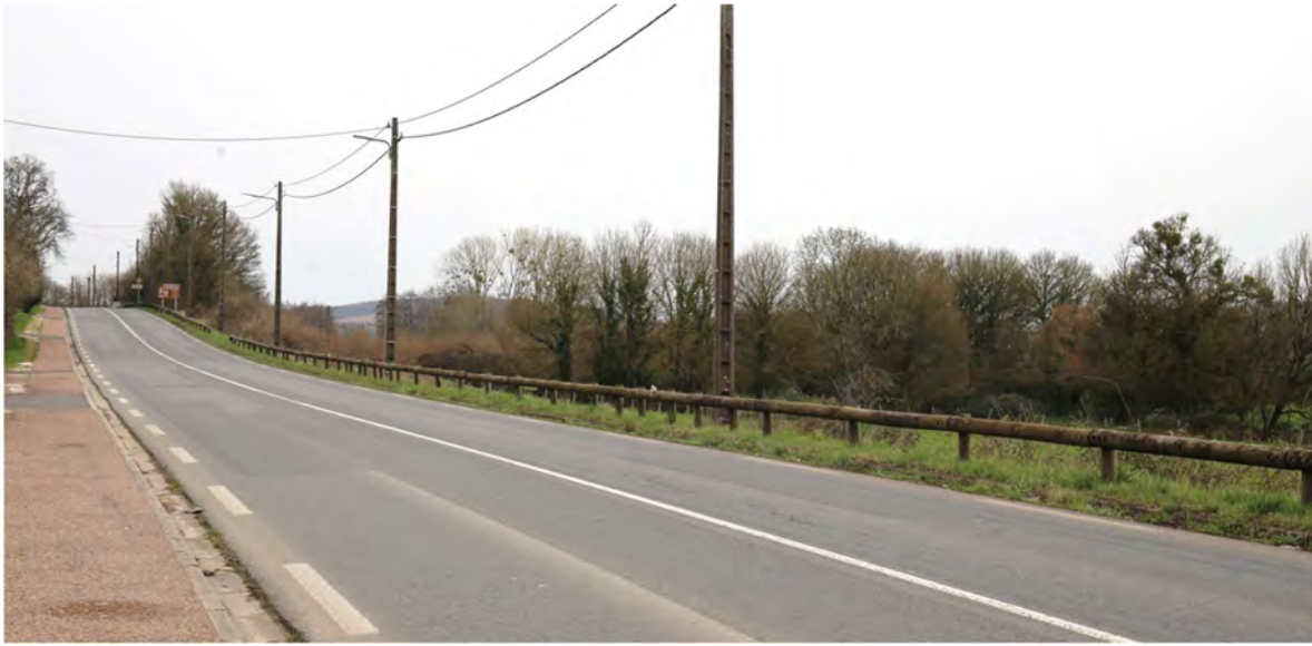
Figure 62 : RD977, panneau entrée de ville de Prémery, les vues transversales s'ouvrent et se ferment au gré des plantations arborées qui bordent l'axe (ici la vue est très fermée en direction de la vallée).
